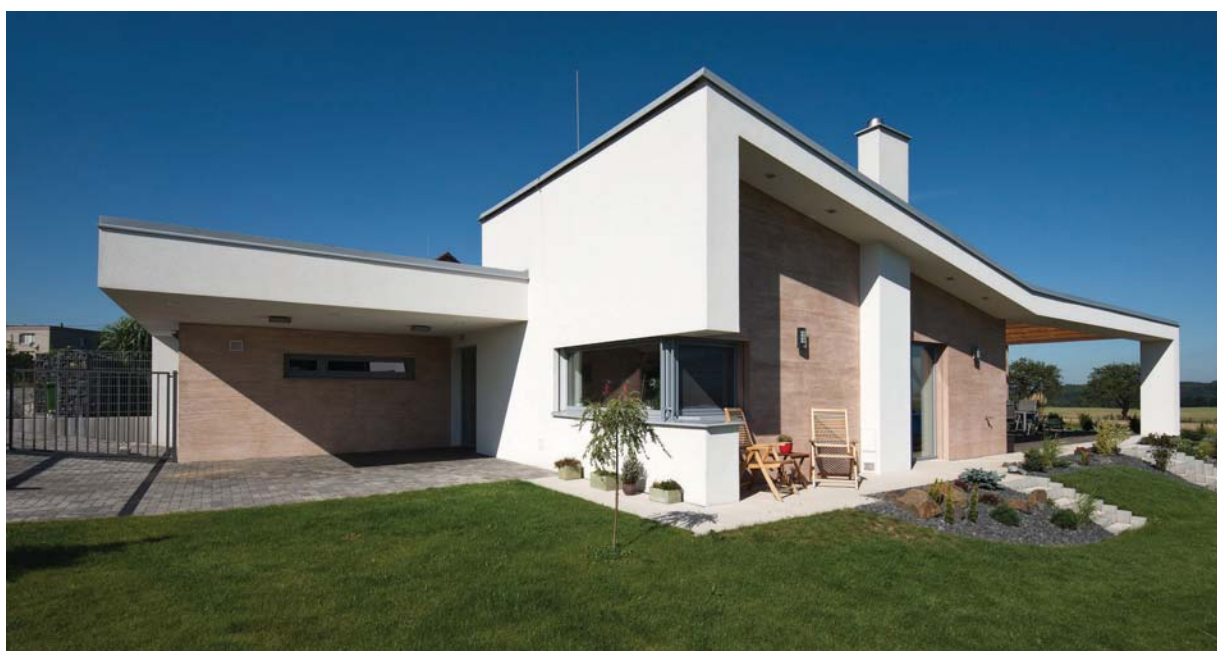
Rodinný dům, Děhylov, 2014. Stavba s nižším rozpočtem, u níž byla snaha dosáhnout „za málo peněz hodně muziky“. Lemující linie nemá jen charakter designu, ale plní funkci stínění, a definuje i prostor terasy.
